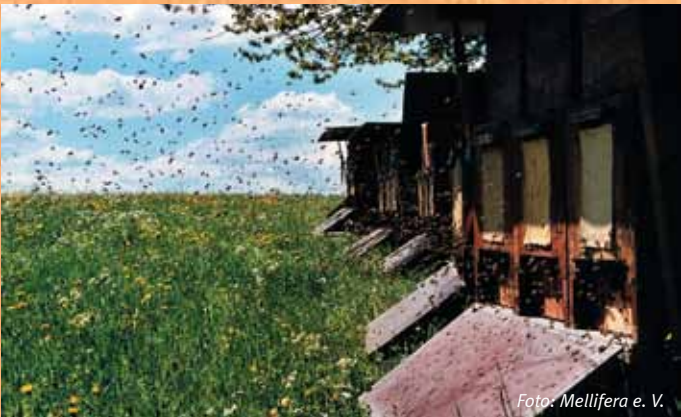
Diese schwäbische Lagerbeute aus einer Holzständerkonstruktion mit Strohänden, die mit einer speziellen Kuhmist-Lehm-Mischung verputzt sind, wurden in den ersten Jahren an der Fischermühle entwickelt.
